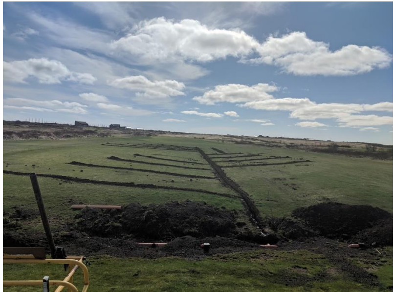
Mynd 3 - Drenframkvæmdir á 11. braut
