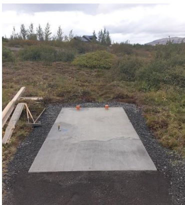
Mynd 4 - Steypt plata undir nýtt salerni
