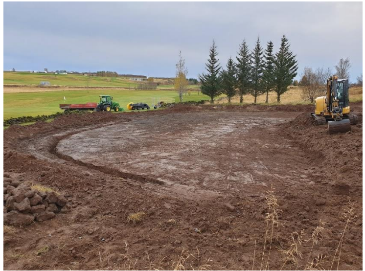
Mynd 5- Botn nýrrar flatar mótaður og drenlagnir grafnar
