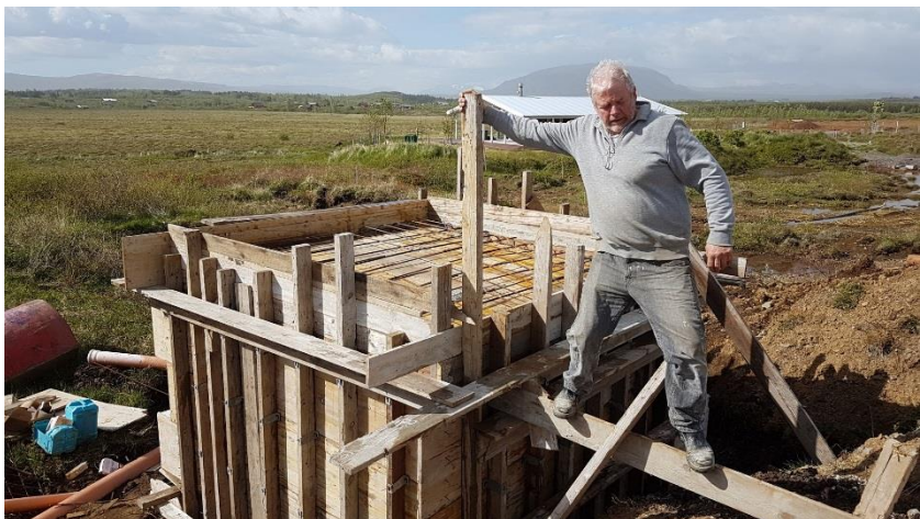
Mynd 1 - Sigggi tekur út dæluhúsið fyrir steypu
